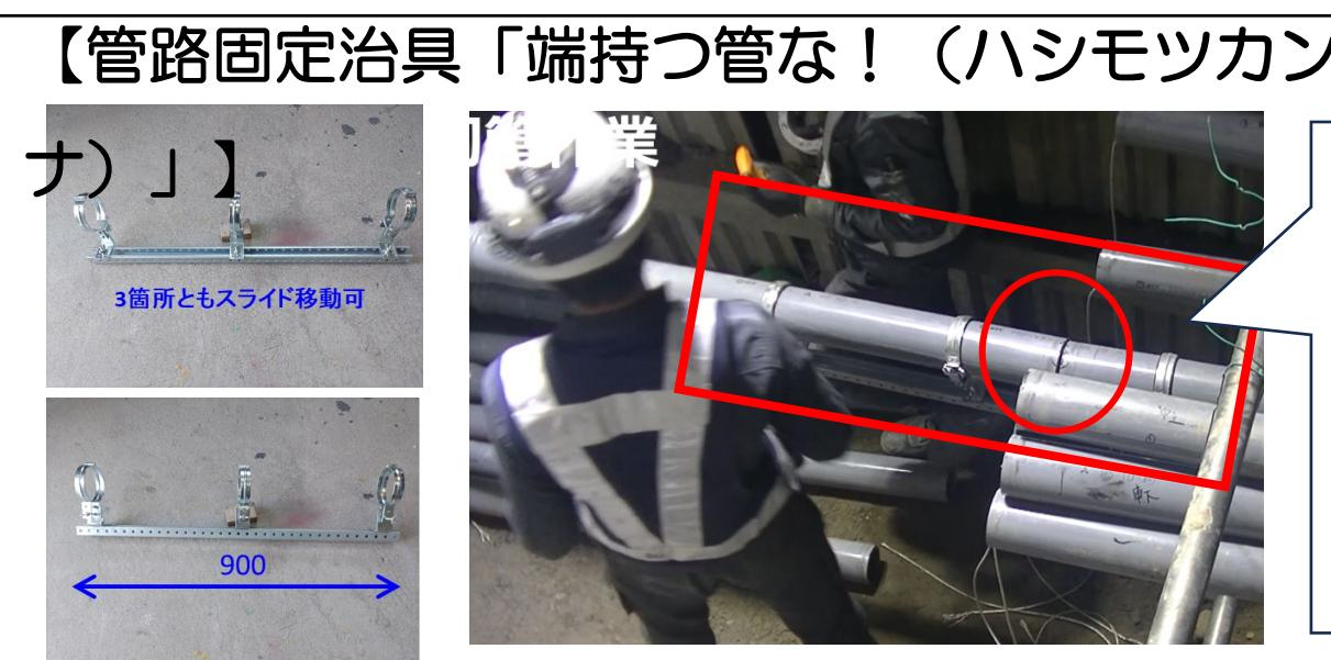
管路固定治具を使用することで切断した箇所が固定され、安全かつ作業効率が図られる
